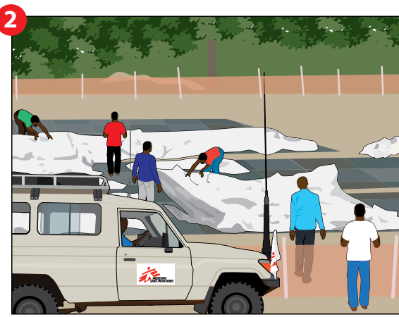
2 On utilise des pompes mécaniques pour gonfler les neuf tentes. Avec des équipes qui travaillent 24 heures sur 24, on peut monter tout l'hôpital en trois jours.
